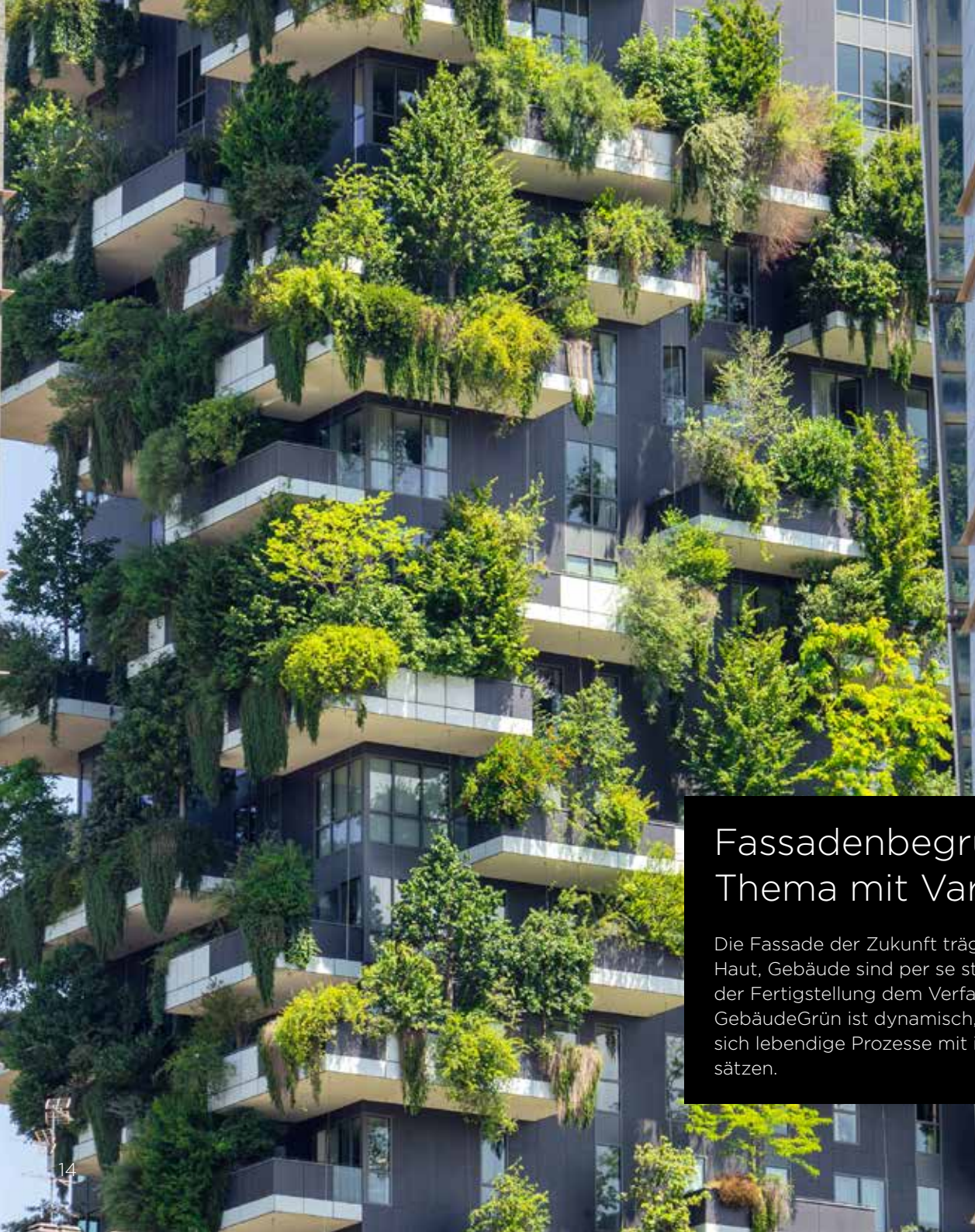
Fassadenausschnitt der begrünten Hochhäuser „Bosco Vertikale“ in Mailand (2017), Planung: Stefano Boeri; E. Boio & L. Gatti
