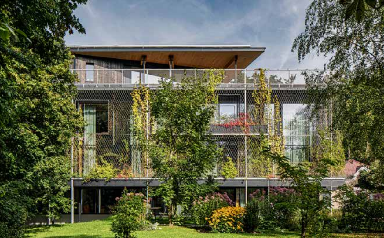
Vorgehängtes Ranksystem an einem Betriebsgebäude in Natters bei Innsbruck. Planung Snøhetta, Innsbruck
